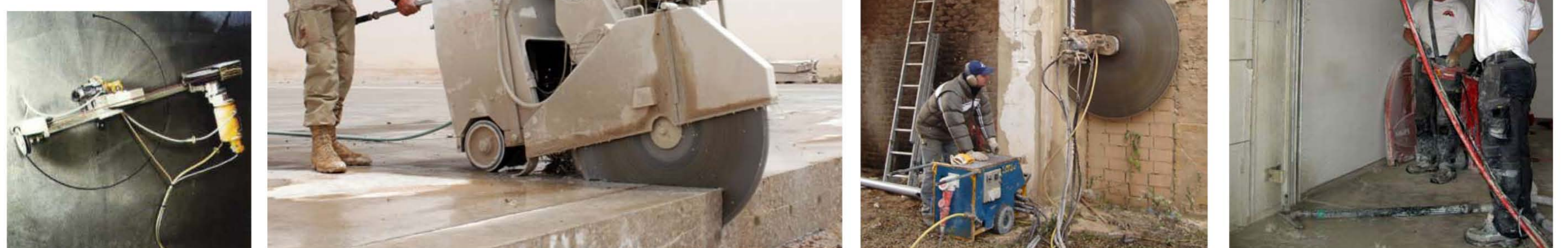
Zirkelbetonsäge (d=7-35cm) Betonsäge für Straßenfugen im Fahrbahnbelag Vertikale Betonsäge, bis 70 cm Sägetiefe Anfertigung von Türöffnungen
