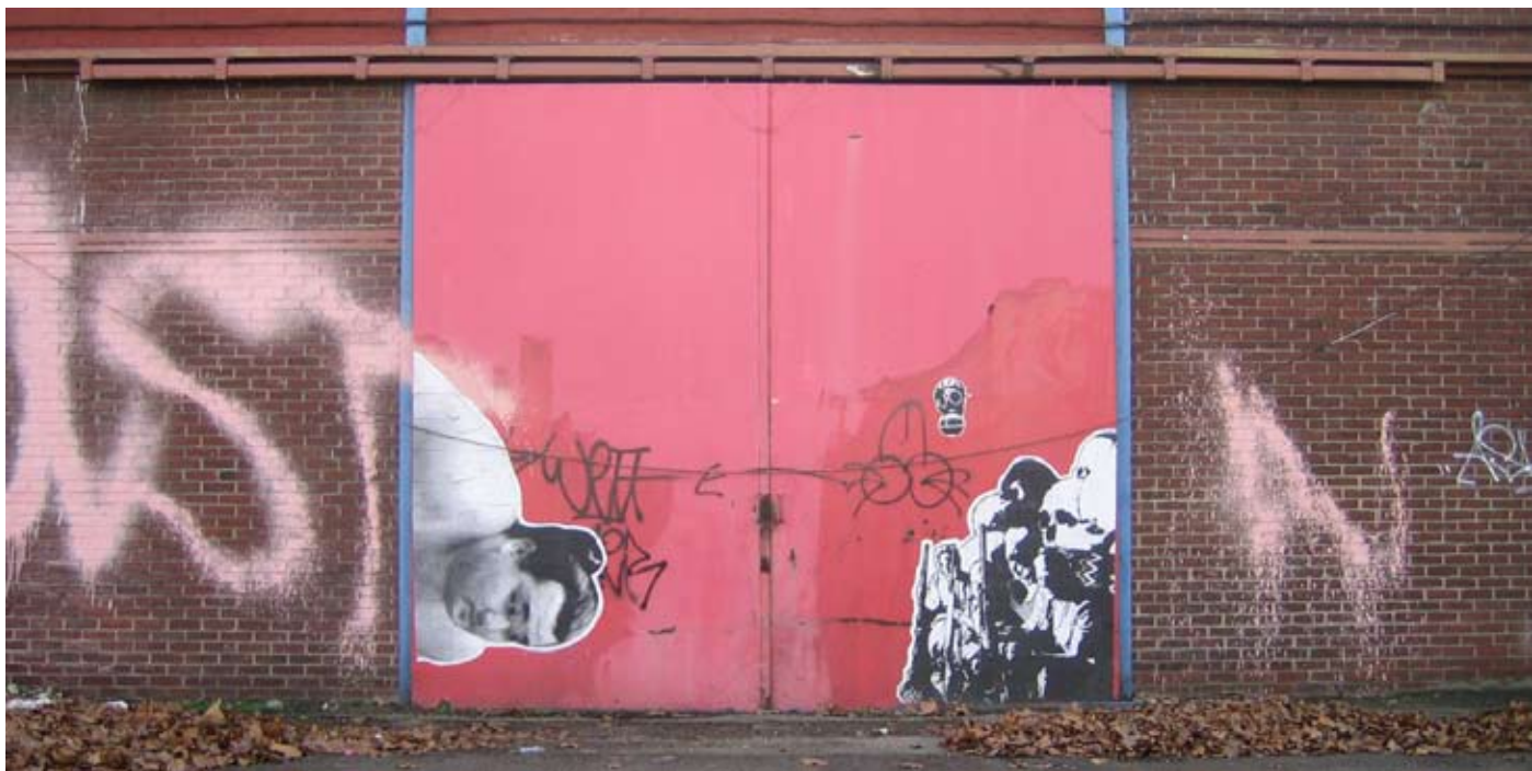
Derrière le hangar 10
