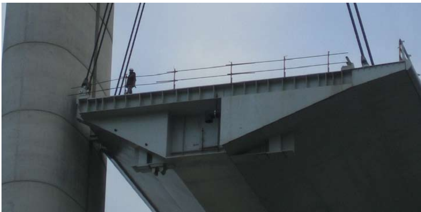
Tablier en position haute
