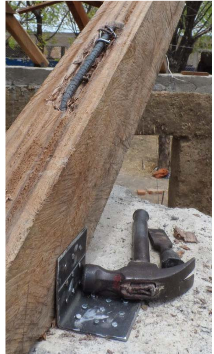
Anschluss Dachauflager
