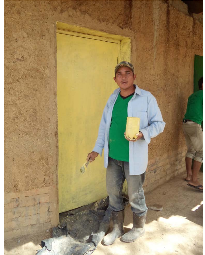
Putz- und Malerarbeiten
